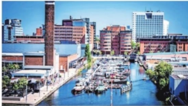
▲ De Binckhorst, een van de grotere bedrijventerreinen van Den Haag. Hier worden de komende tijd duizenden woningen gebouwd. FOTO DANIELLA VAN BERGEN
